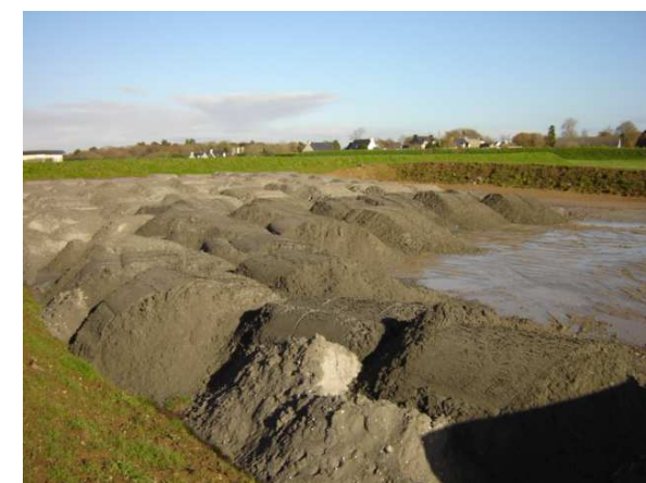
Exemple de reprise en andain des sédiments
