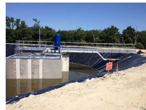
Pompage et refoulement des eaux du bassin de clarification
